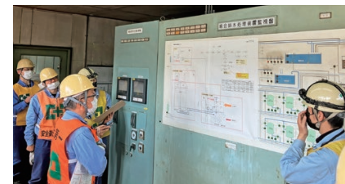
排水処理施設のパトロール
