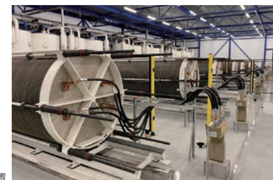
Ovako水素プラントの電解装置
