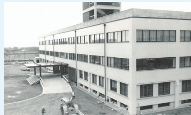
新社屋 (現 本社事務所) 建設 (1964年)
