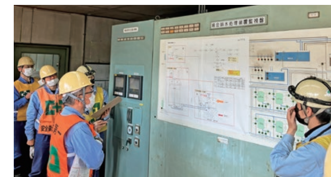
排水処理施設のパトロール
